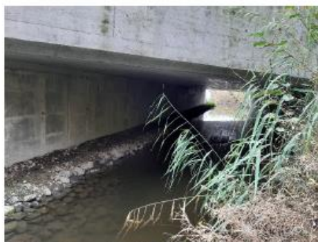
7) Gewässerdurchlass Seeligraben Rütistrasse
