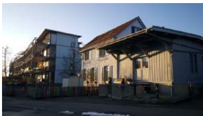
Alter Bahnhof Wolfhausen
