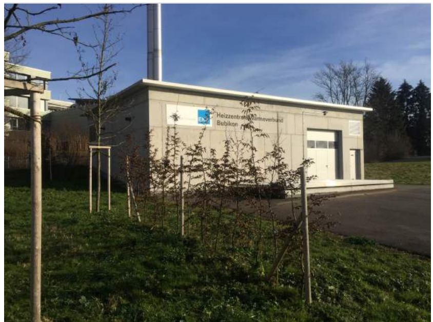
Wärmeverbund der EKZ in Bubikon
