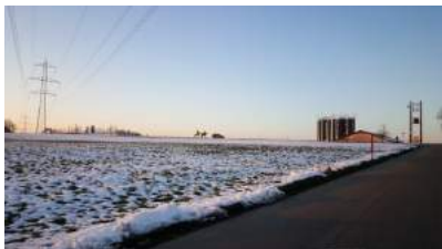
Hochspannungsleitung im Gebiet Bürg
